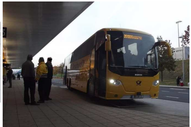
Geräumig geht es am neuen Kölner Fernbushalt zu. Der Warte- und Haltebereich bietet Fahrgästen und Bussen ausreichend Platz, Sitzgelegenheiten und einen entsprechenden Witterungsschutz
